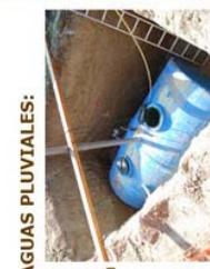
**SISTEMAS DE RECOLECCIÓN DE AGUAS PLUVIALES:** Las aguas de lluvia son recogidas y canalizadas por tuberías que van a un depósito enterrado y por medio de una bomba es transportada a unas cisternas que se encuentran en la zona de máquinas del edificio. Siempre que se necesite agua no potable, se surte de las aguas pluviales almacenadas.
